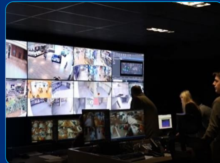
Central de Monitoramento
